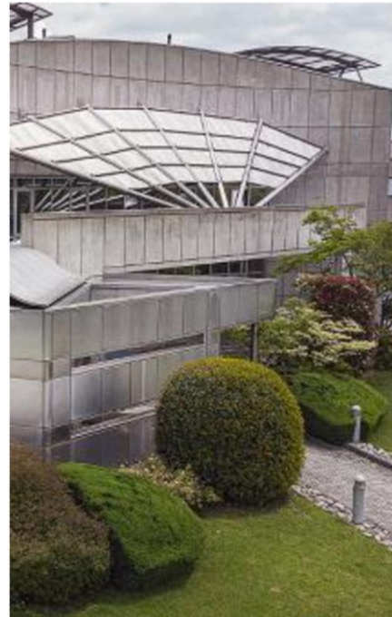
L'impianto di Basiano di Cpc Inox
