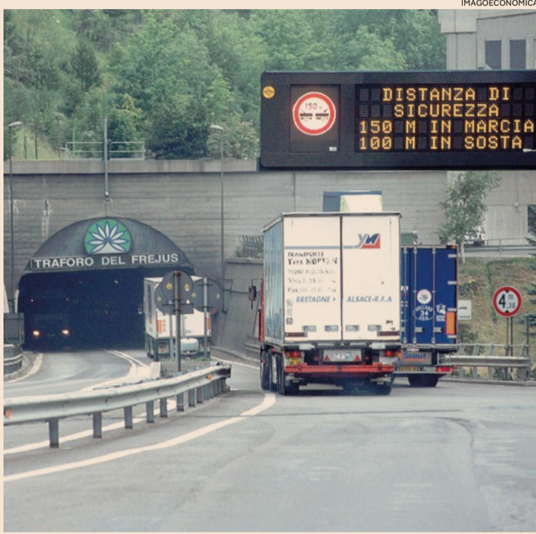
Tra il Piemonte e la Francia. L'imbocco lato Italia del tunnel stradale del Frejus
